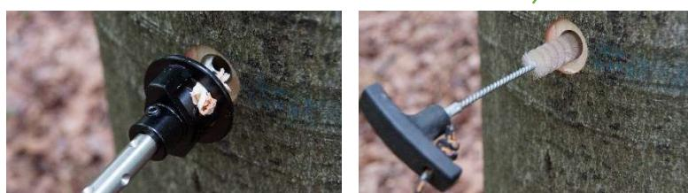
Réaliser le perçage progressif , nettoyer le trou de forage, désinfecter le trou, introduire la résine, visser le boulon de plateforme.
