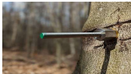
2.3.8 Eindrehen der Plattformholzaufnahme mit inox guard
