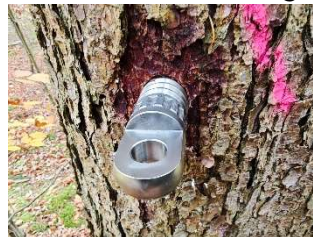
2.3.8 Eindrehen der Plattformholzaufnahme mit inox guard
