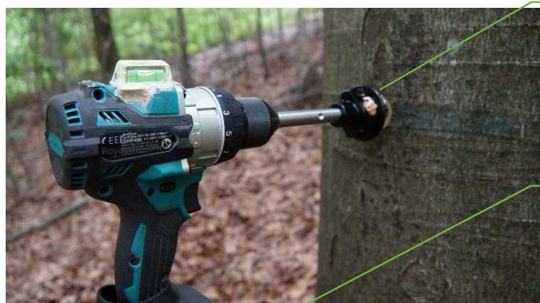
Installer le premier boulon de plateforme en tenant compte de la notice d'installation pour les boulons de plateforme (« Rev A // 06-06-2024 »).
