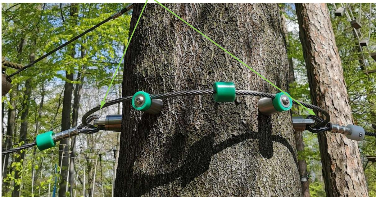
Il convient de veiller à ce que le câble n'endommage pas l'écorce de l'arbre, par exemple par frottement. Le cas échéant, une protection contre l'abrasion (ici porte-câble, voir aussi 2.6) doit être installée.
